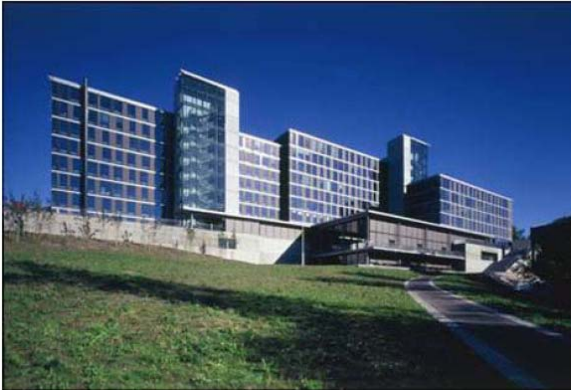
Energiintensivt kontorbygg, ca. 35000 m 2
